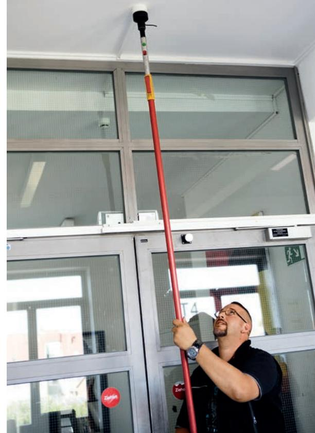
Mit einem Pflücker lassen sich die Rauchschalter einfach aus dem Bajonettverschluss des Sockels herausdrehen, was einen Austausch ohne Einsatz einer Leiter ermöglicht.
