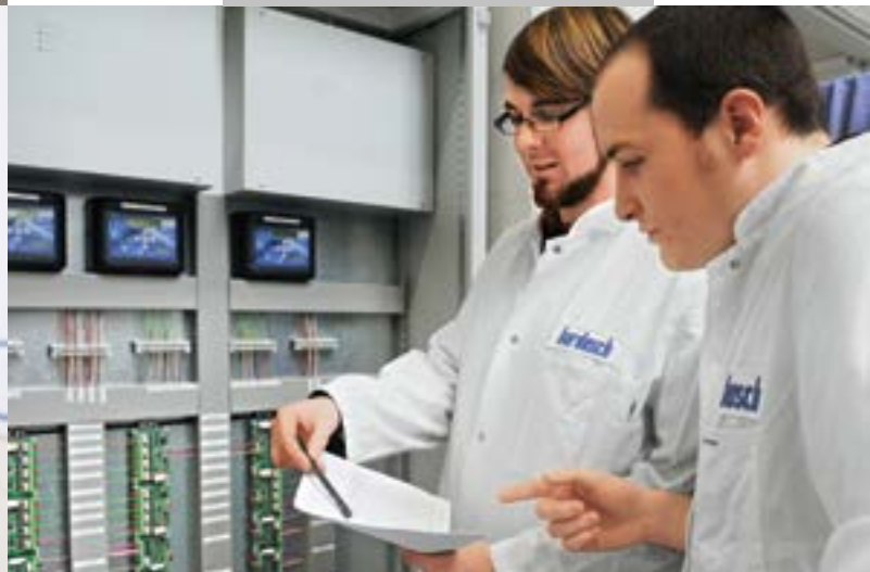
Im Eingangsbereich erlaubt ein Handfeuermelder die manuelle Alarmierung (links). Stefan Gnahn und Reinhard Lerner (von links) von Elektro Ludwig überprüfen die Kontrolleinheiten der Ilia-Dust-Melder.
