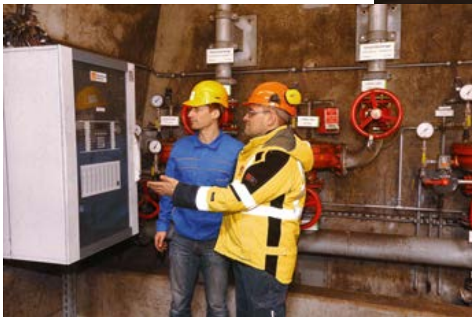
Heiko Beyer (rechts), Techniker der Kraftanlagen-Gruppe, erläutert Thomas Winkler von Vattenfall die Ansteuerung der Wasserlöschanlagen durch die Steuerlöschzentrale Integral IP.
