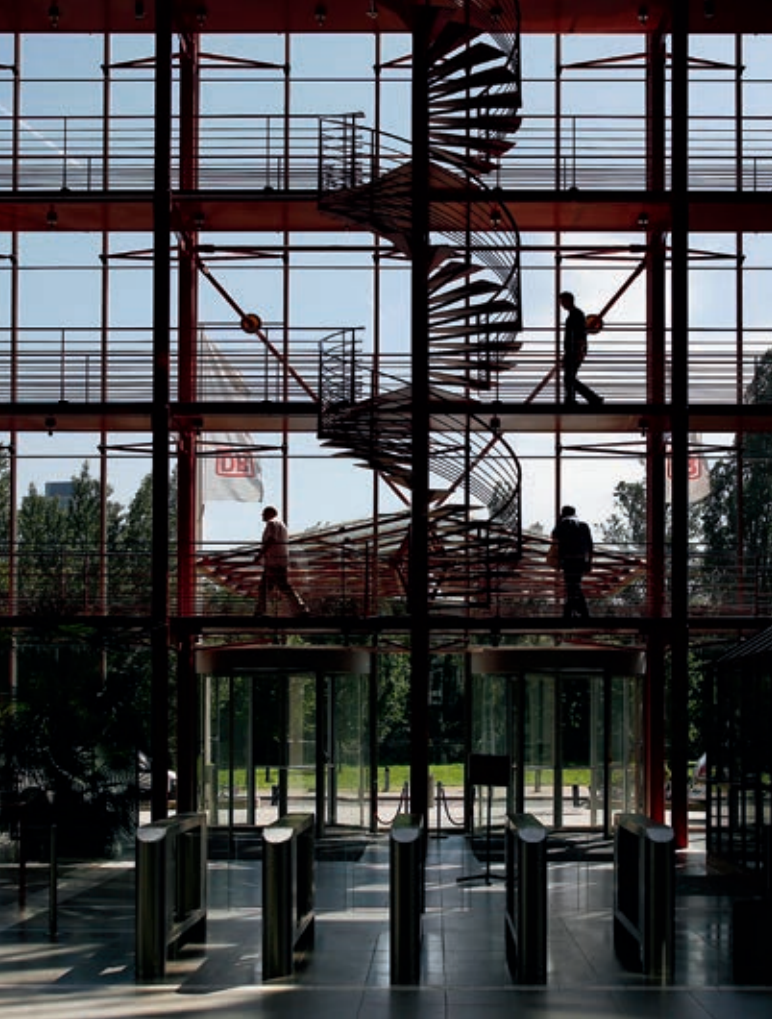
In der mehr als 16 Meter hohen Eingangshalle überwachen linienförmige Rauchmelder den Luftraum.
