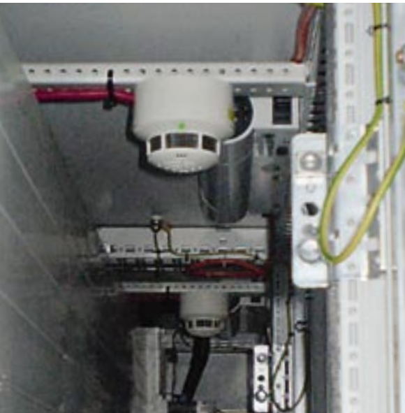
Komplett modular: Die gesamte Peripherie rund um den Bohrturm ist in Containern mit Standardmaßen untergebracht. Diese und insbesondere die Schaltschränke werden durch optische Rauchschalter abgesichert.
